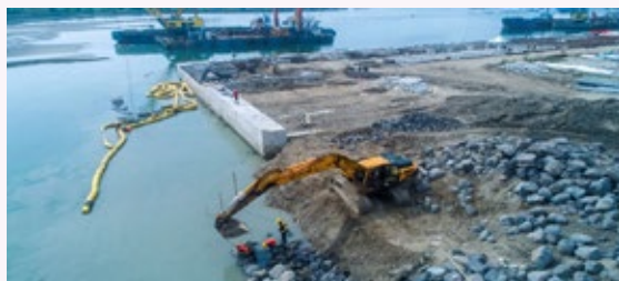
Pemancangan SPSP/Pilling SPSP
