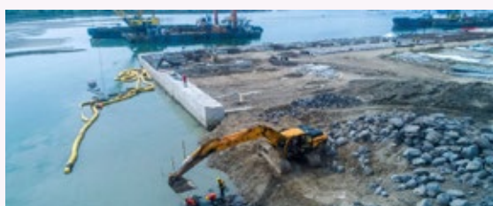
Pemancangan SPSP/Pilling SPSP
