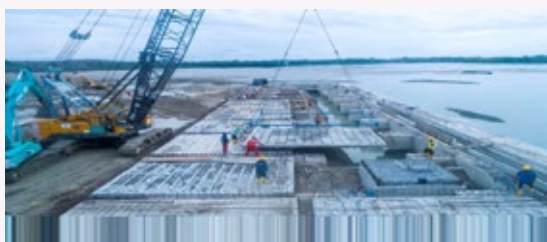
Pemancangan CSP/Pilling CSP
