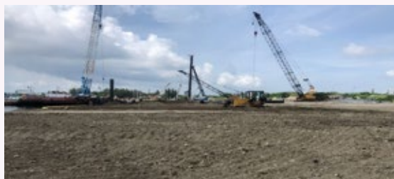
Pekerjaan Timbunan Tanah/Land Deposit Work
